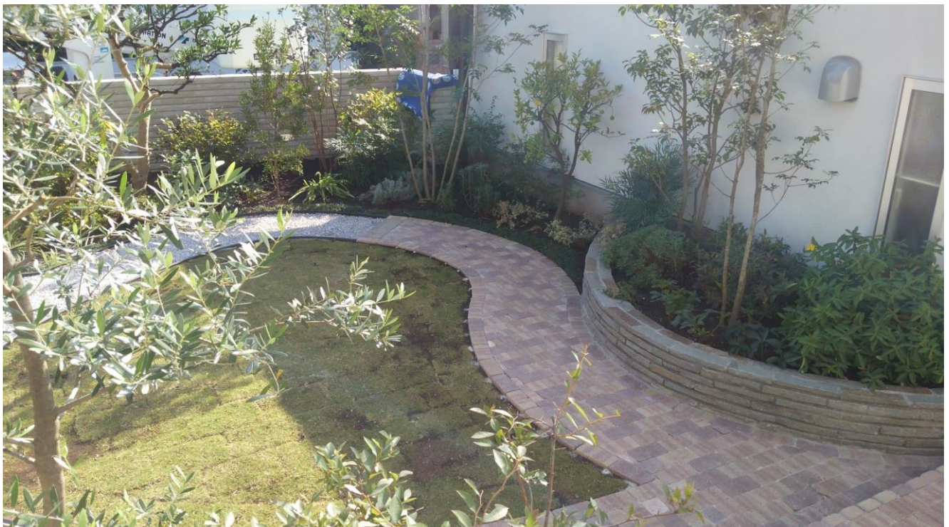
戸建 植栽工事
