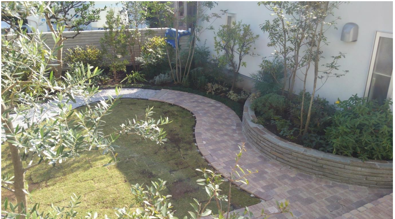
戸建 植栽工事
