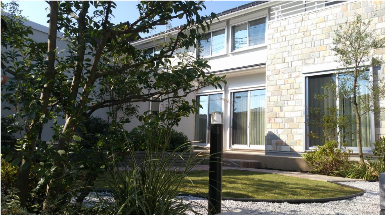
戸建 植栽工事
