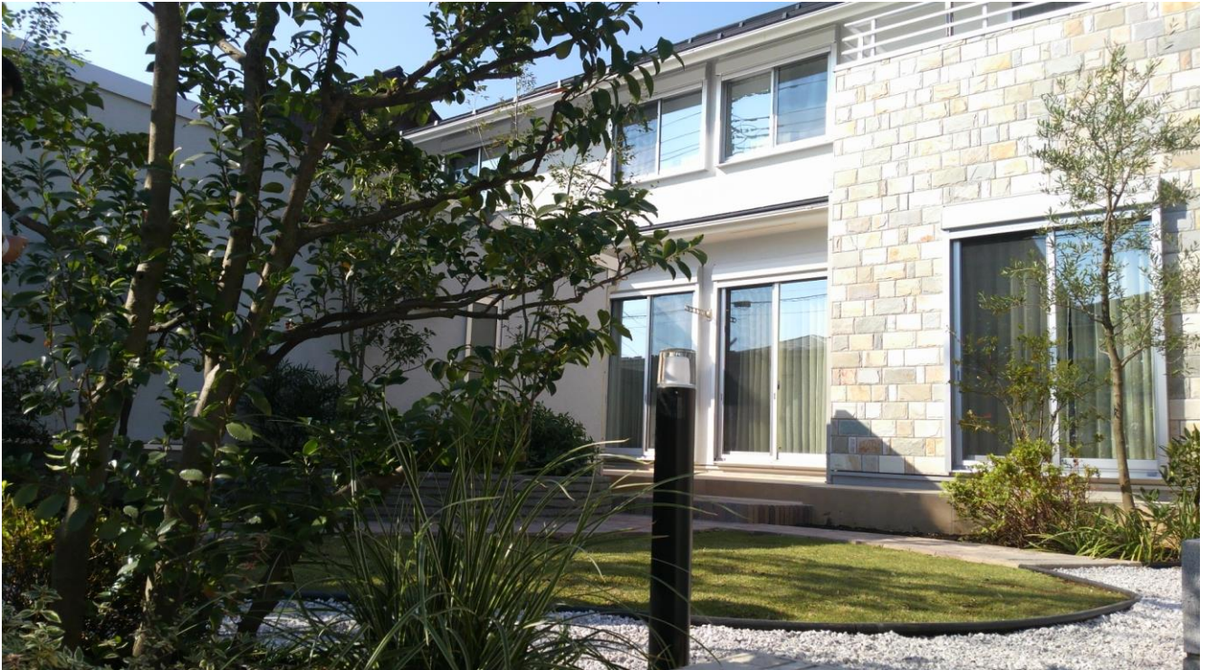
戸建 植栽工事
