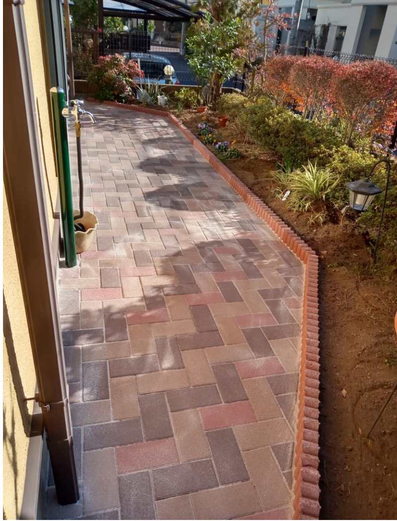
庭床改修工事
