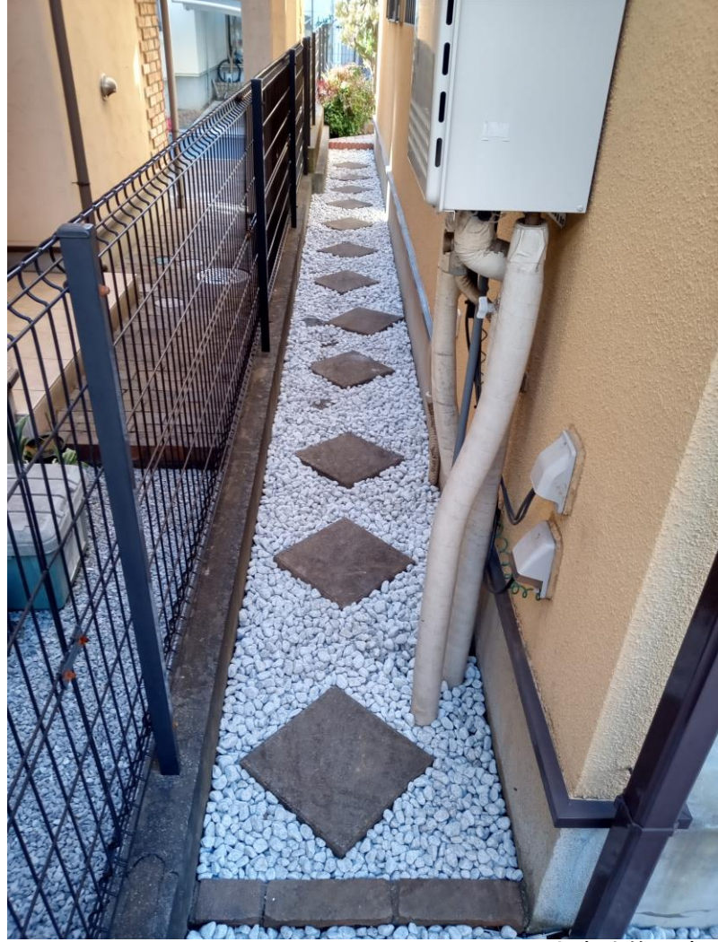
犬走改修工事
