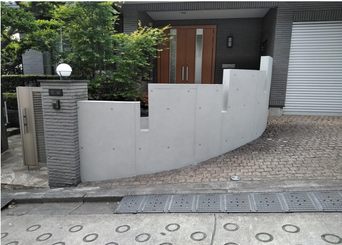
◆メイキング工事
