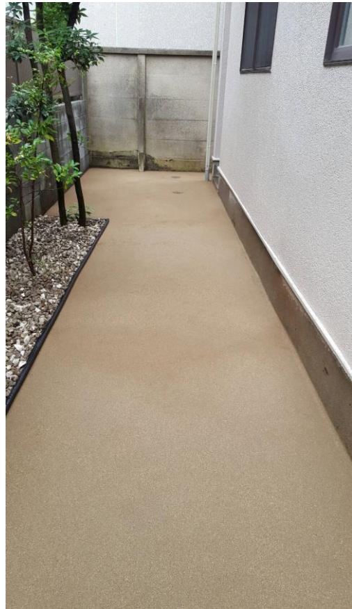
◆マサド改修工事
