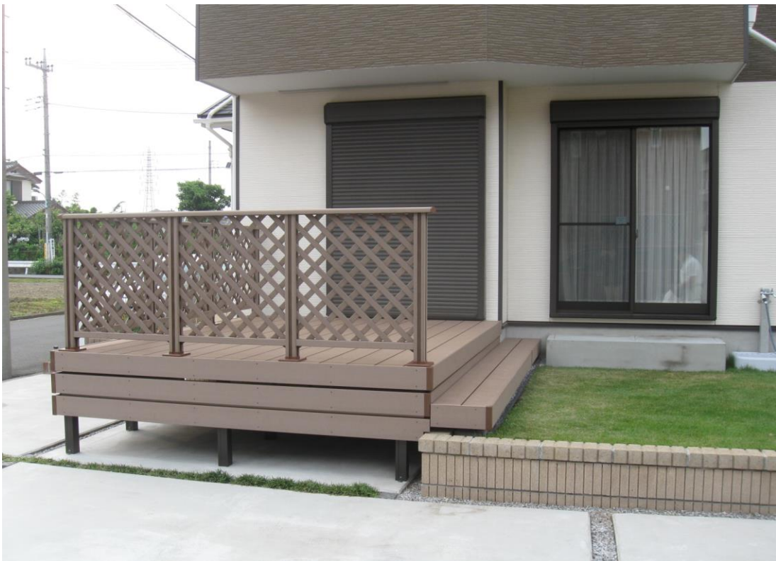
◆木樹脂デッキ工事
