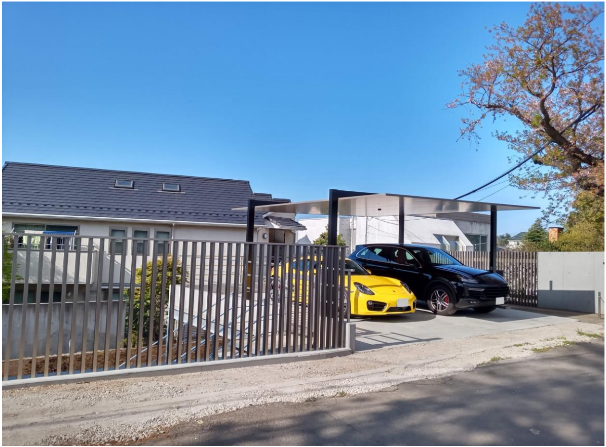
鉄骨駐車場工事
