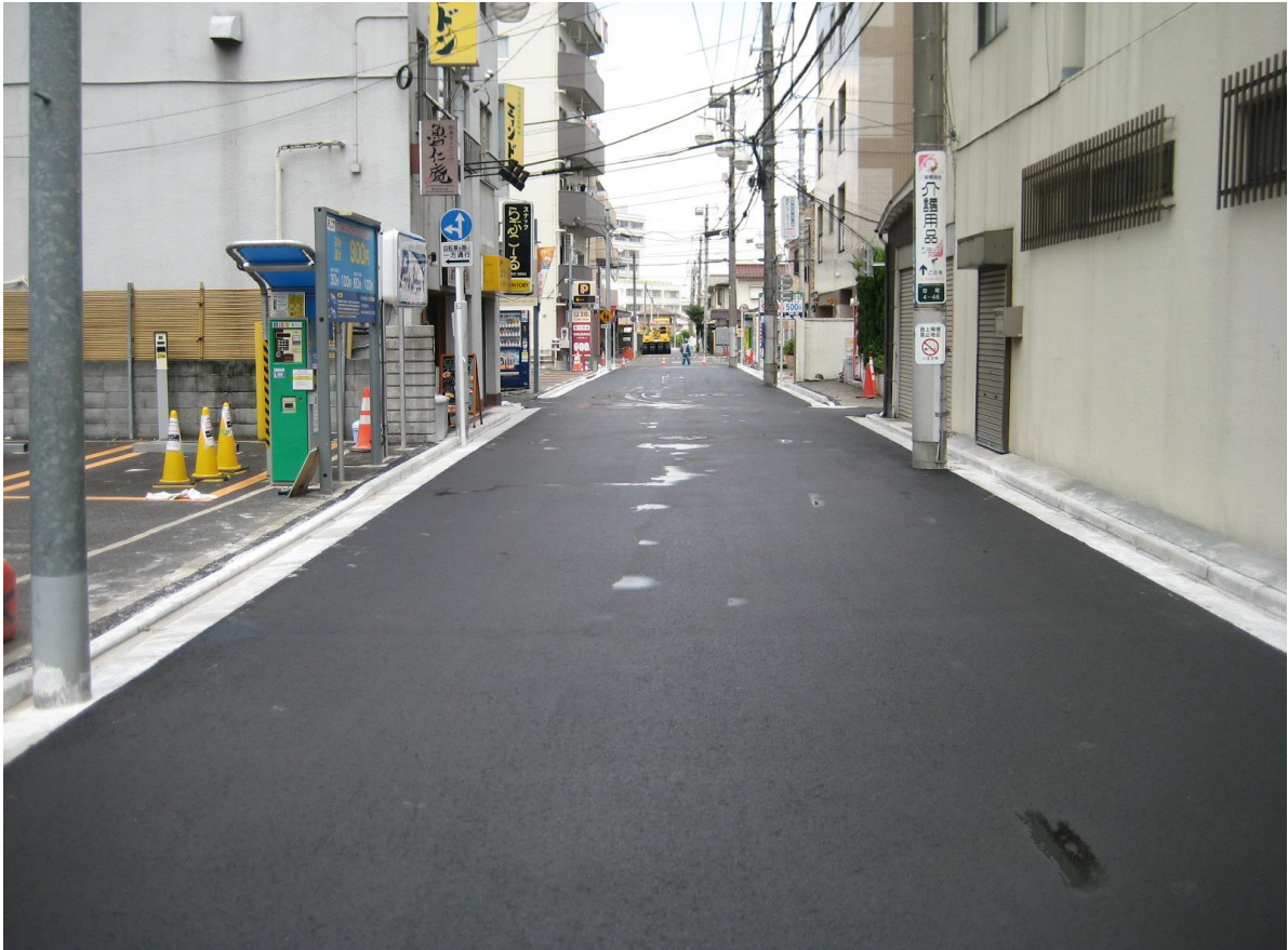
アスファルト舗装工事
