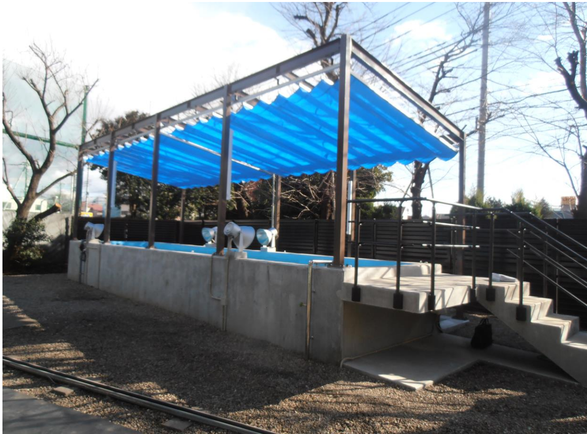
試験プール工事
