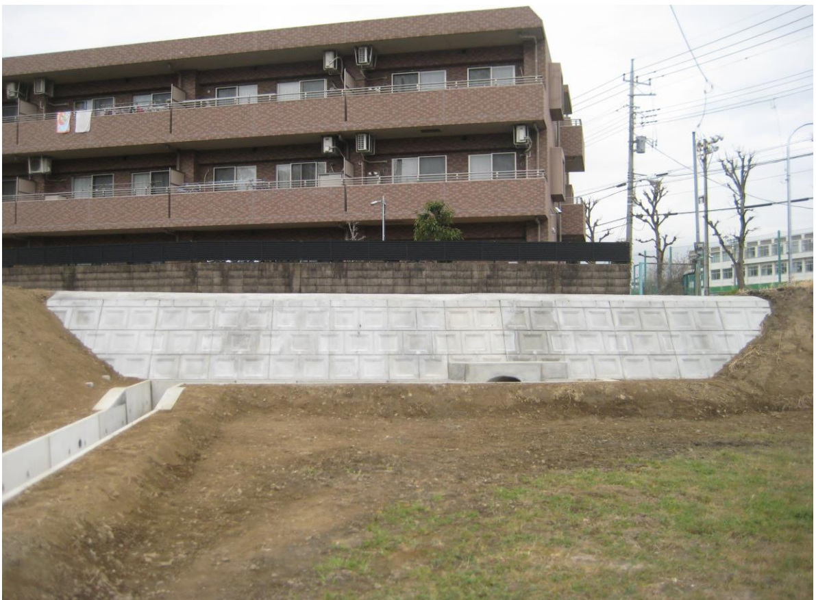
張りブロック工事
