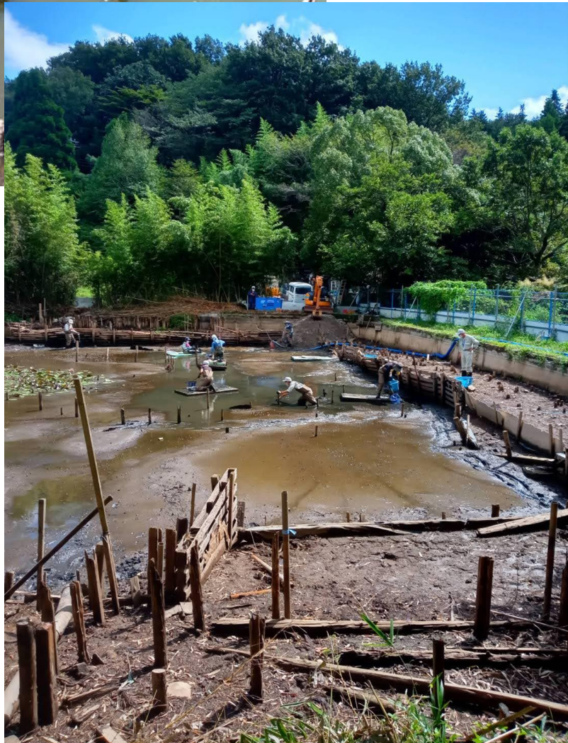
八王子市某所貯水池水抜き工事
