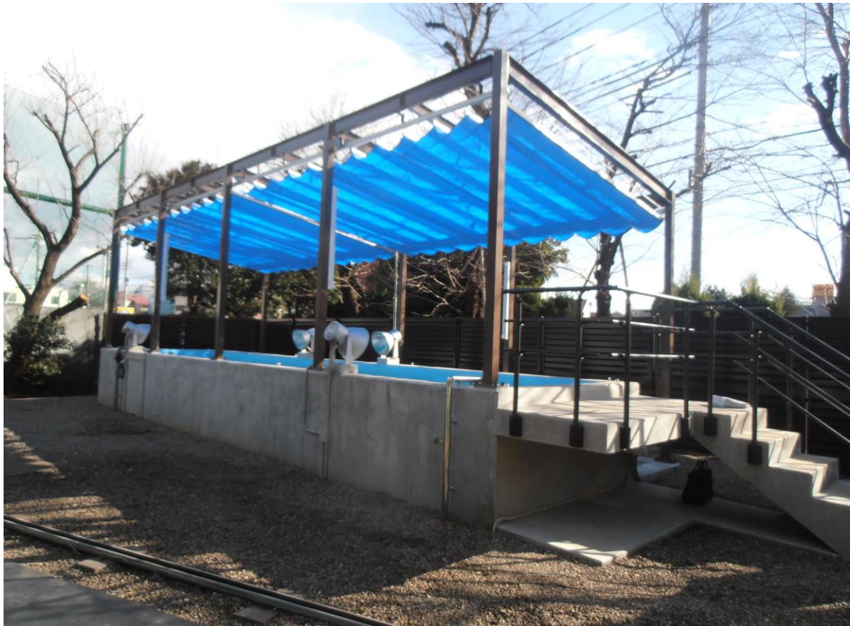
試験プール工事
